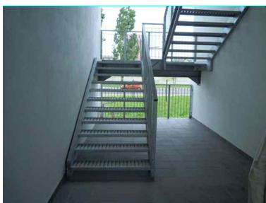
Le scale fisse hanno gradini con pedate e alzate di dimensioni adeguate. Sono dotate di corrimano da almeno uno dei due lati di altezza minima 100 cm. Gli scalini non sono scivolosi. Quelli delle scale di emergenza sono in metallo traforato e gli scalini della scalone interno hanno la parte terminale bocciardata antiscivolo.
