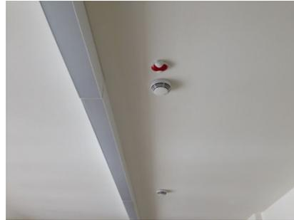
Nei locali tecnici come centrale termica e cucina sono installati sensori di calore e temperatura; mentre per il monitoraggio dei canali d'aria, nella sezione ripresa, sono installati dei rilevatori per condotte.
