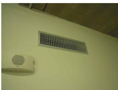
Ogni locale servito integra un controllo autonomo della temperatura ed umidità tramite sensore non manomissibile posto in ogni stanza, garantendo così una climatizzazione adattabile alle singole esigenze ed alle diverse funzioni.
