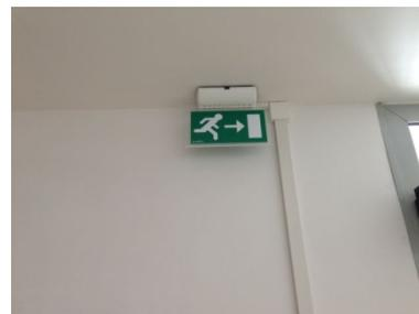
Le vie di fuga e le uscite di emergenza hanno altezza minima di 2 metri e larghezza minima di 120 cm. Le uscite di emergenza sono raggiungibili con distanze conformi al DM 18/09/2002 (norma prevenzione incendi per le case di riposo) e sono dotate di sistema di facile apertura nel verso dell'esodo. Al momento dell'ultimo sopralluogo le uscite di emergenza erano libere da ostacoli e facilmente raggiungibili dai luoghi di lavoro.
