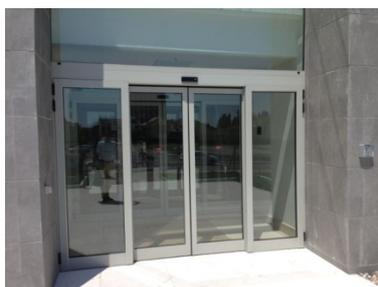
In caso di assenza della corrente elettrica la porta scorrevole elettricamente di ingresso, che funge da uscita di emergenza, si apre facilmente a mano e le due porte laterali si aprono a spinta nel verso dell'esodo.
