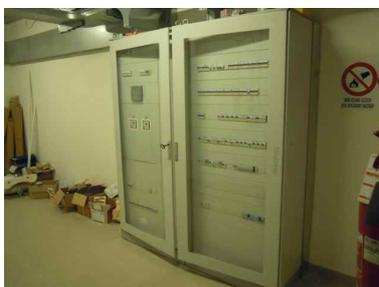
Presente interruttore di sgancio della corrente elettrica dell'edificio nel quadro elettrico generale al piano interrato.
