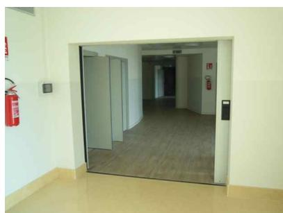
Le porte REI sono installate correttamente. Quelle sempre aperte solo collegate all'impianto rivelazione e allarme incendi per mezzo di elettrocalamite.
